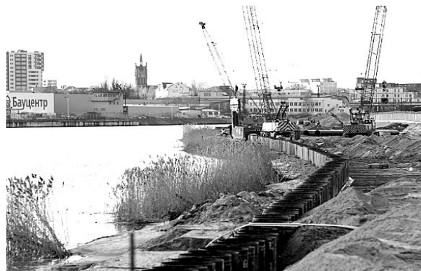
Строительство объектов к чемпионату мира по футболу 2018 года, Калининград
